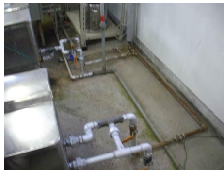
図3-19 蒸気の配管
